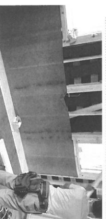
施工中の様子。灰色の布状のものが導電性シート(写真提供：レジナ)
